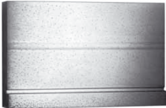
Typisches Erscheinungsbild korrodierter Oberflächen
